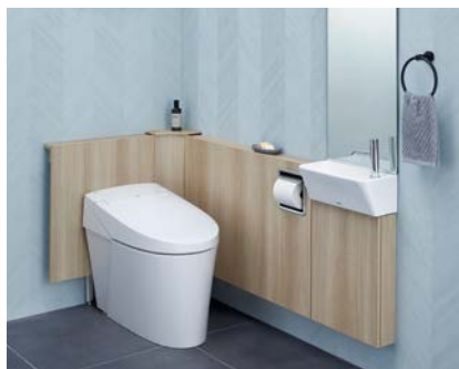
既設の給排水を利用した手洗付きのトイレリフォームに
