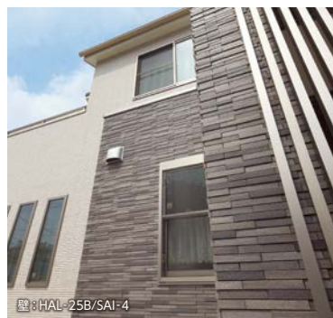
〈ボーダーネット張り(馬踏目地)〉
