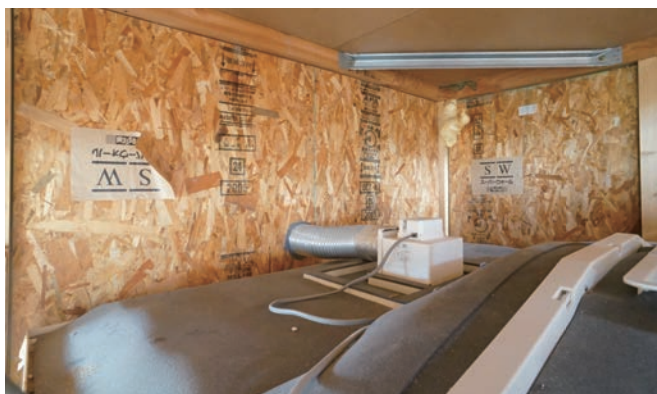
湿気が溜まりがちな浴室天井裏もカビやシミなどのない、きれいな状態を維持している。
