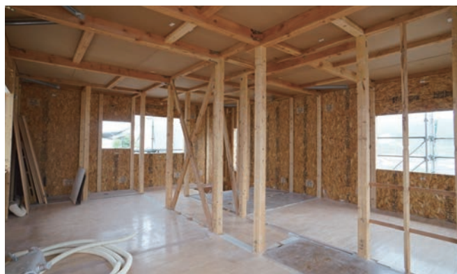
築17年の家を解体したとは思えない新築現場のような状態。室内側もOSB仕様の断熱パネルのため、断熱材の様子は下の写真に。
