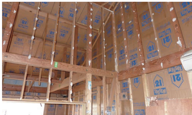
解体時に内装壁や下地材を剥がした状態。20年以上前に施工された断熱パネルは、きれいなままで大きな劣化は見られない。
