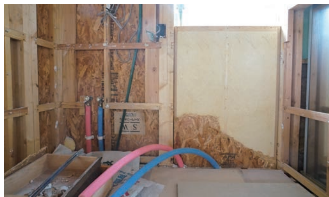
洗面窓下のOSBを剥がして断熱材を現した状態(正面の黄色い部分)。断熱材の大きな劣化は見られない。
